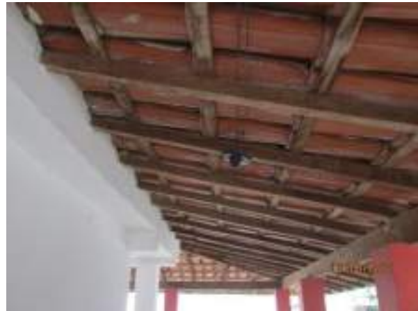
FIGURA 26 - ARMAZENAMENTO IRREGULAR DE RSS NO ESF-E (EXTENSÃO)
