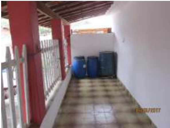
FIGURA 25 – ARMAZENAMENTO IRREGULAR DE RSS NO ESF-E (EXTENSÃO)
