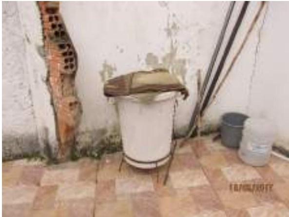
FIGURA 23 – ARMAZENAMENTO IRREGULAR DE RSS NO ESF-E (FONTE: ACERVO DO AUTOR, 2017)
