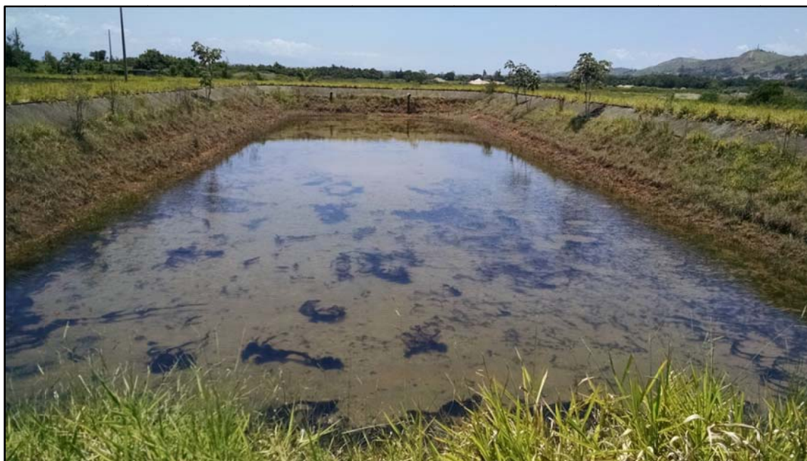
Figura 7. Lagoa Anaeróbia com Afloramento do Lençol Freático
